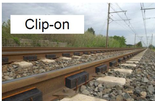
Figura nr 4: Amortizor de zgomot CORUS, aplicat
